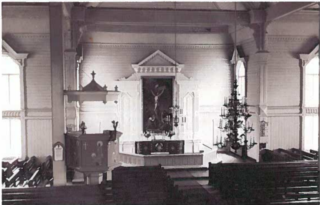
Kuvat: Ylhäällä kirkon alttari kuvattuna ilmeisesti 1800- ja 1900-lukujen vaihteessa. Alhaalla Foto Albin Aaltosen ottama kuva vuoden 1935 muutosten jälkeen. Kattoratsastaja lisäsi merkittävästi katon painoa. Saarnatuolin vieressä näkyy yksi neljästä lisätystä tukipilarista. Kangasniemen seurakunnan kuvapankki.
